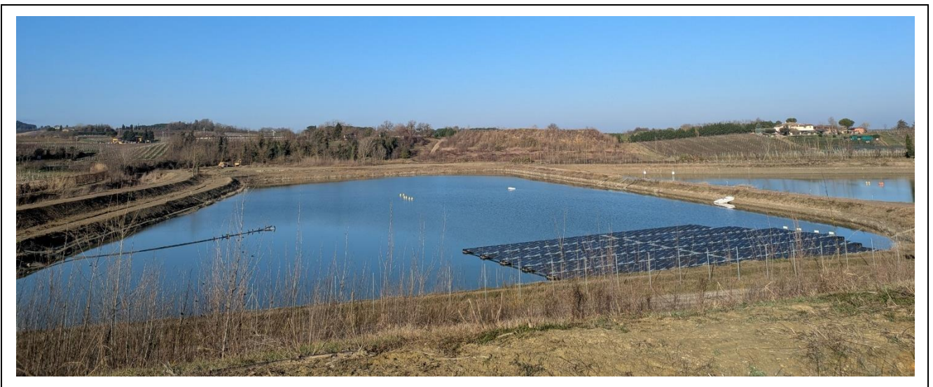
I laghetti Santa Lucia-Rivalta con pannelli fotovoltaici flottanti
